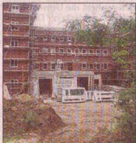
Noch haben auf der Baustelle am Gojenbergsweg die Bauarbeiter das Sagen.
